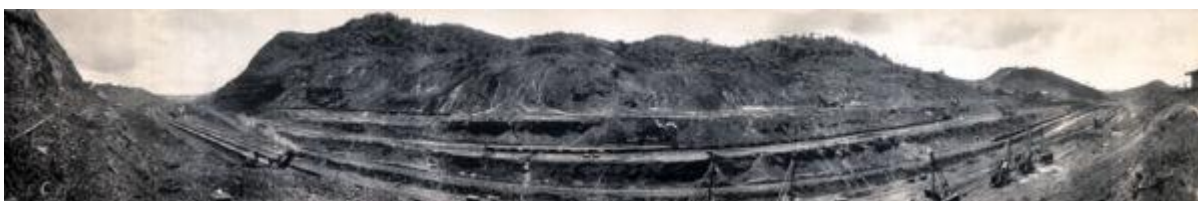
fasi della costruzione del canale di panama
